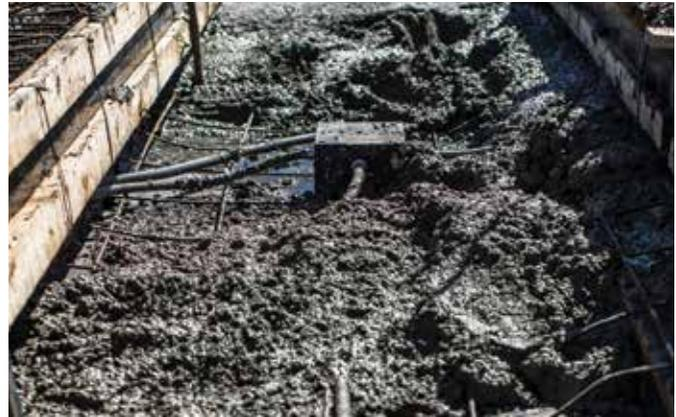
el encofrado y solo queda a la vista la luminaria propiamente dicha, sin marco. Para algunos diseños arquitectónicos esta es una gran primicia, ya que minimiza absolutamente la presencia de las luces, que se ven como parte de la losa y solo cobran relevancia al encenderse.
